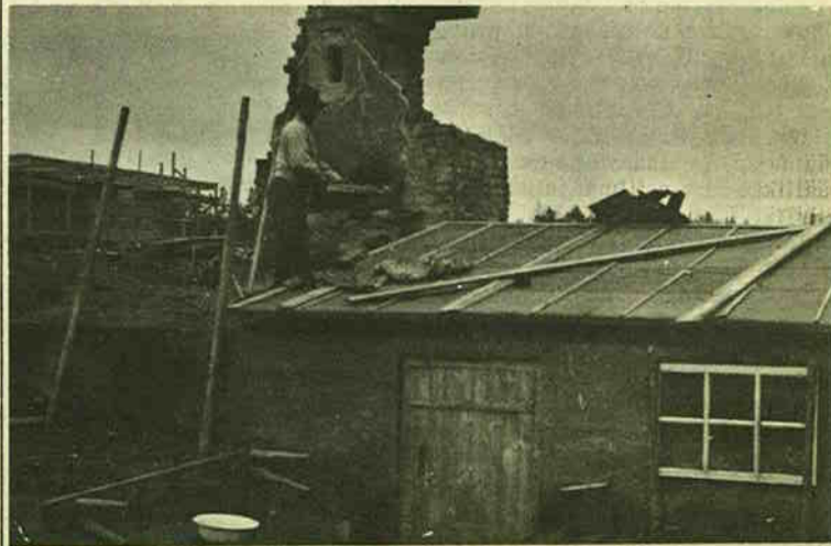
Voihan leipää paistaa, vaikka talossa ei olekaan seiniä. Aleks Salku Kitelästä leipäunin lämmityspuuhissa.
