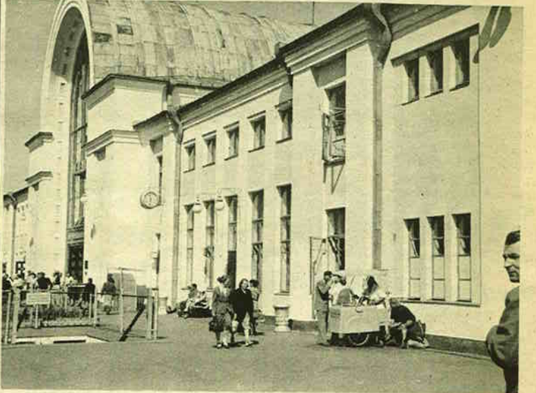
Terijoen nykyinen rautatieasema. Entiseen verrattuna siitä puuttuu laiturikatos ja kattorakennelma on muuttunut.
