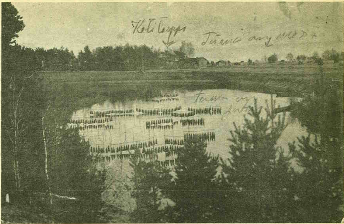
Vammeljoen ja meren yhtymäkohtaa kyläläiset kutsuivat Joensuiksi. Tässä kohdassa olivat kalastajien venealkama ja silmumertojen kuivaustelineet. Nahkiaisten (silmujen) pyynti aloitettiin elokuun 15. pnä ja sitä jatkettiin pakkasten tuloon asti. Vanhallasahalla Lintulanjoen ja Vammeljoen yhtymäkohdassa oli toinen silmujen pyyntipaikka.
